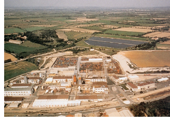
COMURHEX Usine de Malvesi
