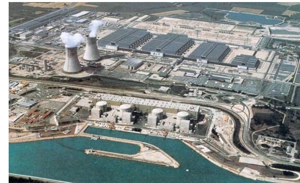
L'usine EURODIF fermée en mai 2012.
