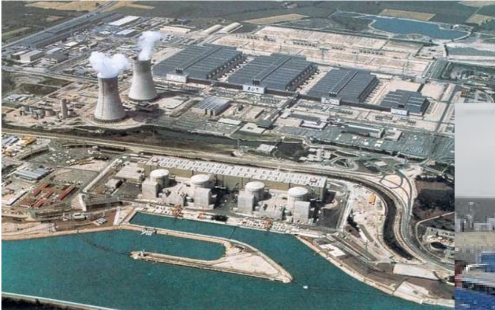
L'usine EURODIF fermée en mai 2012.
